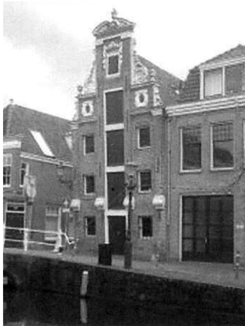
De handelsgoederen die vanuit Azië werden aangevoerd naar de Nederlanden, werden eerst opgeslagen in de pakhuizen van de diverse Kamers; daarna werden ze verdeeld over diverse handelsplaatsen in de Nederlanden bestemd voor veiling Voorbeeld van een VOC-pakhuis, De Vigilantie, in Alkmaar
